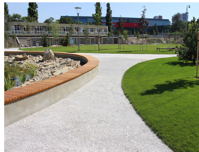
probarvený drenážní beton
